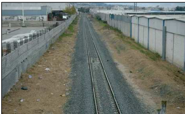
Foto 3. Paso de la vía del tren.
